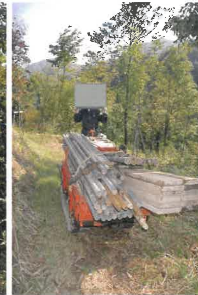
運搬車による機材搬入の例
